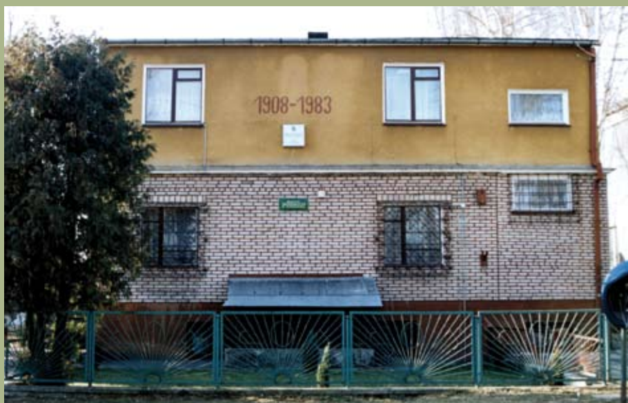
Nowa siedziba Kasy w Czemiernikach z 1969 r.
