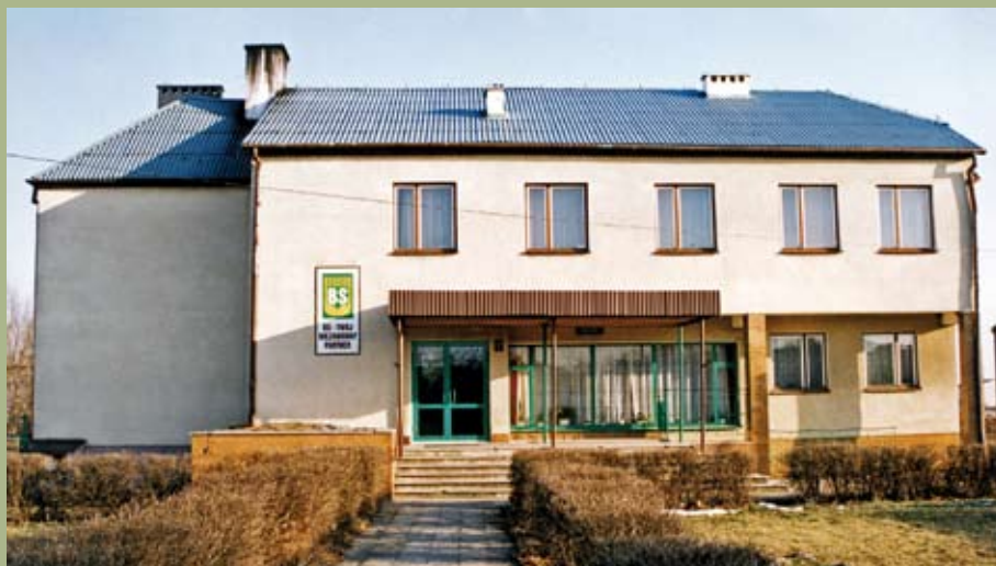
Budynek przed modernizacją
