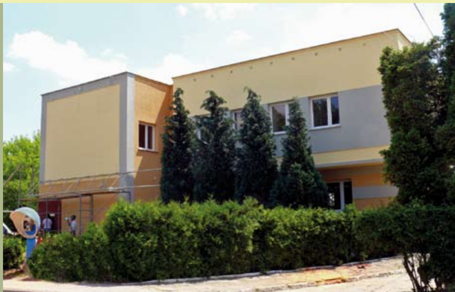
Budynek po modernizacji
