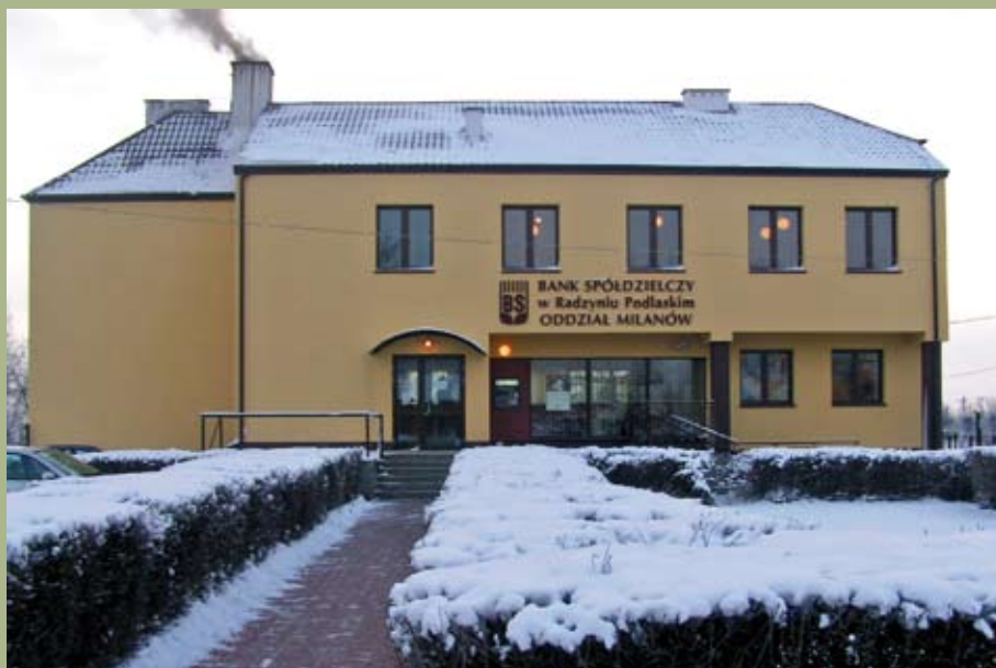
Budynek po modernizacji
