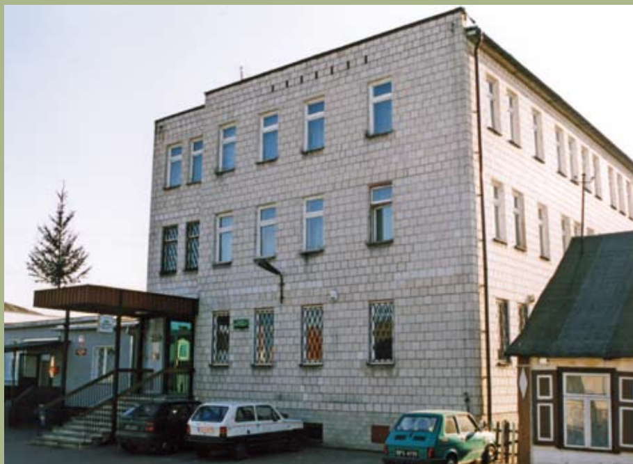
Budynek przed modernizacją
