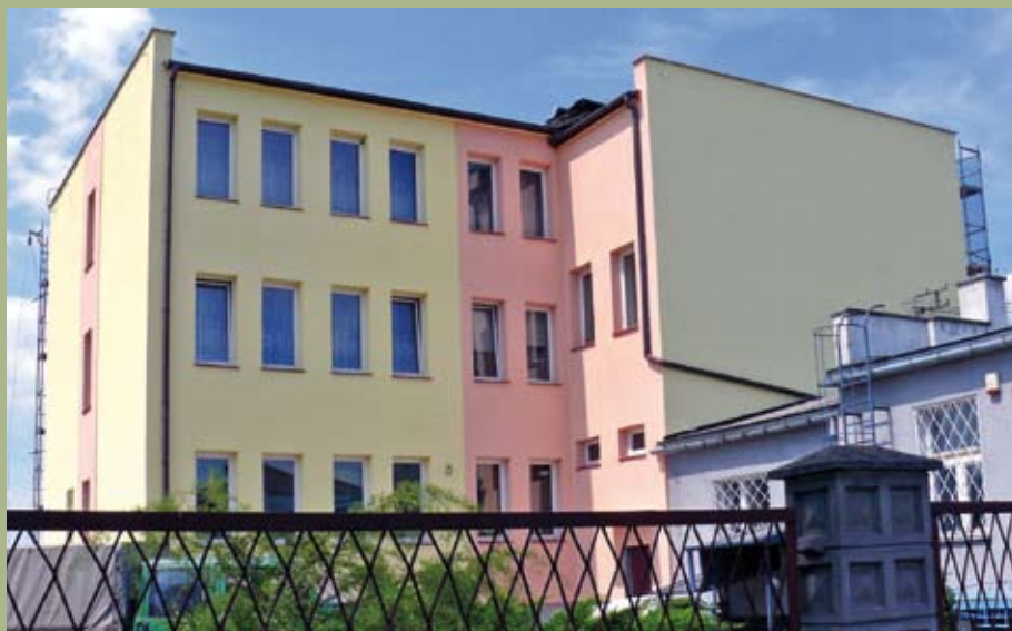
Zdjęcie po modernizacji
