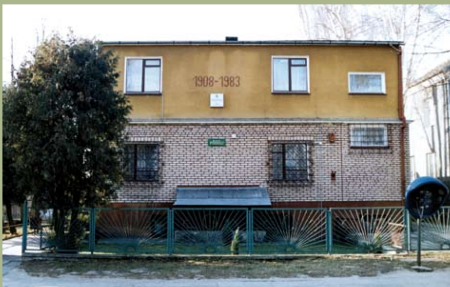
Budynek przed modernizacją
