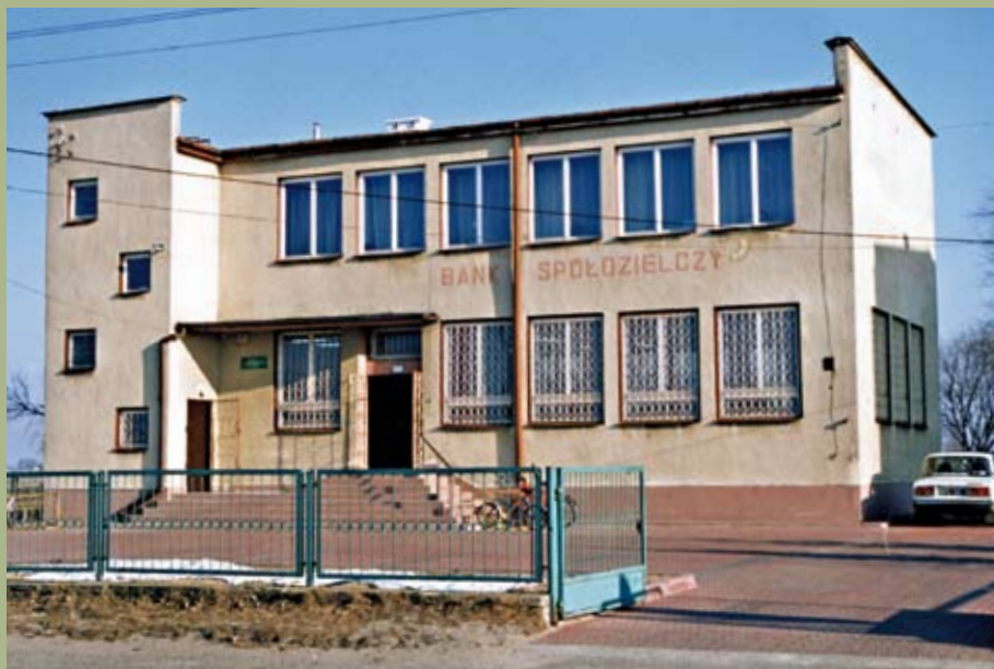
Budynek przed modernizacją
