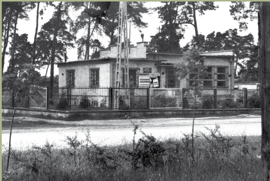
Budynek przed modernizacją
