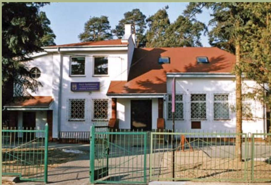
Budynek po modernizacji
