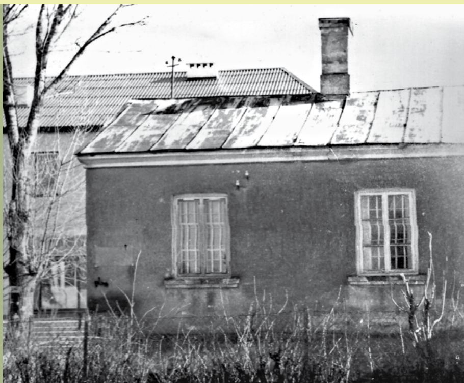
Budynek, w którym mieściła się pierwsza siedziba Banku w Milanowie
