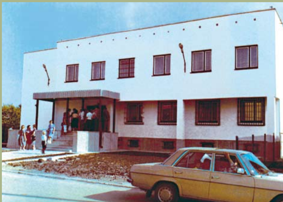
Budynek Centrali przed modernizacją
